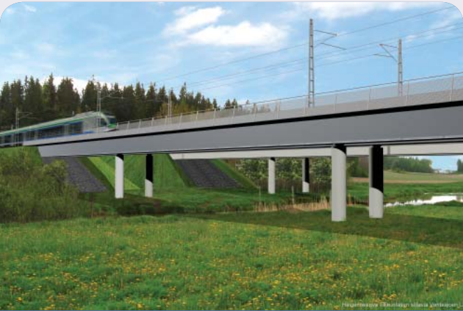
3 Vantaanjoen ratasilta pohjoisesta. Taustalla suunnitellun Tikkurilantien silta
