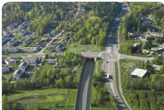
6 Tunnelin itäinen suuaukko
